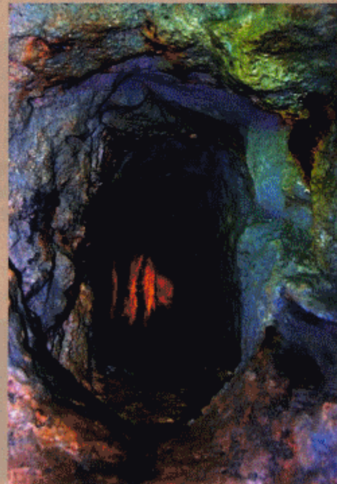
南部藩制時代の手掘り坑道 幅60cm (2尺) 高さ90cm (3尺) の手掘り坑道は南部藩制時代のもので坑内で見学できます。「2尺3尺坑道」と云われます。
